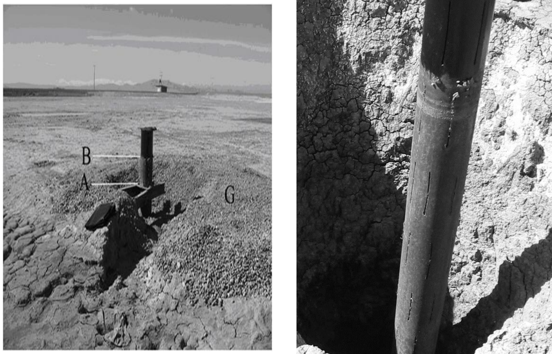
شکل شماره ۷- ساختمان چاه های تغذیه و وضعیت شن ریزی آنها (G)، شستشوی شن ها پس از آبیاری استخرها و فرونشست زمین سطح اولیه زمین (B) و سطح زمین پس از فرونشست (A) می باشد.
