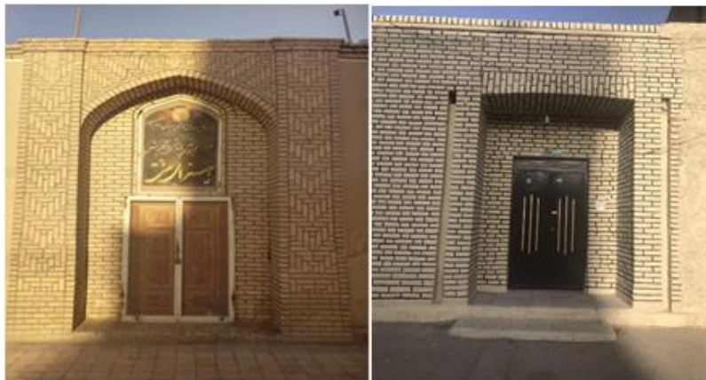
شکل (۲): سردر و عقب نشستگی در بناهای مسکونی دوره پهلوی در شهر زاهدان با ساختار آجری
