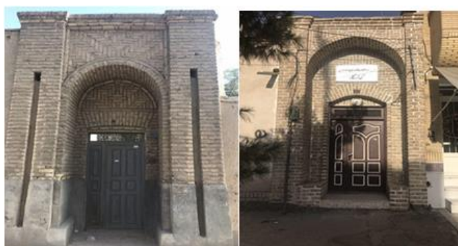
شکل (۱): سردر و عقب نشستگی بنای مسکونی دوره پهلوی در شهر زاهدان
