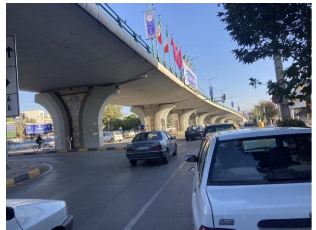
Fig. 12. Haft-e dey overpass
