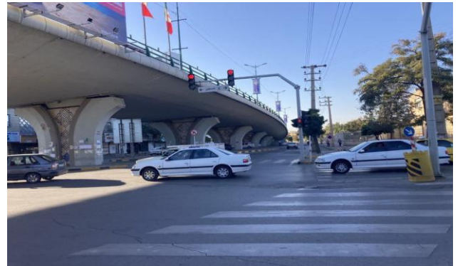
Fig. 11. Noh-e dey overpass
