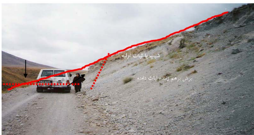
شکل (۶) خطر وقوع ریزش های سنگی در جاده ای واقع در کمرکش ارتفاعات متشکل از مواد آذرآوری در بخش اعظم سال (انتھائی ترین جاده در بخش غربی حوضه)
