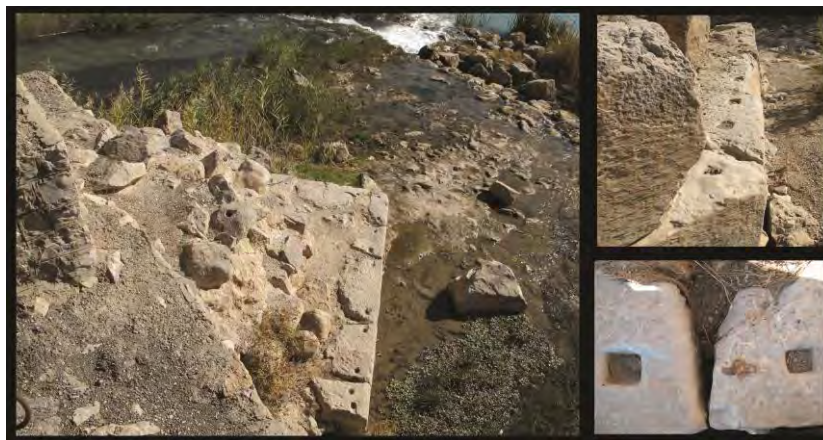
تصویر ۲۳: آبشکن‌های مثلثی و بستهای فلزی به کار رفته در ساختار پایه‌های پل خسرو (عکس‌ها از: مژگان خان‌مرادی).
