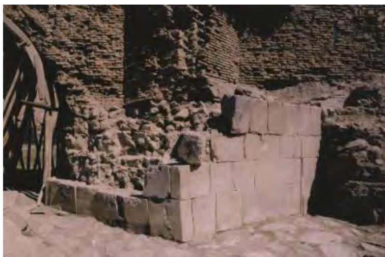
تصویر ۲۶: نمونه ای از فرم چیدمان پایه های ساسانی پل بیستون (مرادی، ۱۳۸۱: ۱۷۹، تصویر ۴۴).
