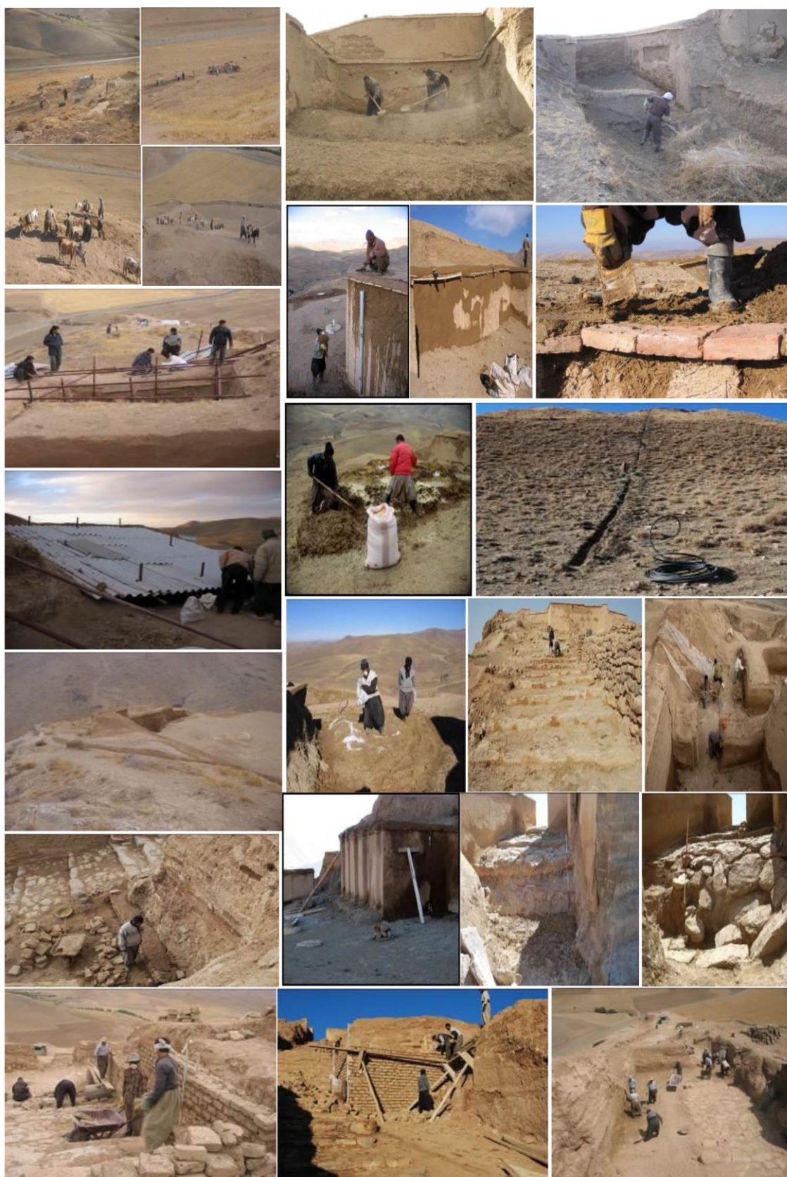
شکل ۱۱: تصاویری از اقدامات حفاظتی محوطه دژ زیویه که در سال‌های ۱۳۸۶ تا ۱۳۸۸ به‌منظور حفظ بهتر این اثر تاریخی انجام شد. این اقدامات شامل پاک‌سازی محوطه، حمل مصالح، انتقال آب، اصلاح و تثبیت راه‌پله ورودی، ترمیم رخ‌بام‌ها، شیب‌بندی و هدایت آب‌های سطحی، مقاوم‌سازی، انجام اندود حفاظتی (کاه‌گل)، شمع‌بندی، پوشش سقف، ساماندهی فضاهای معماری بر اساس پلان‌های کاوش‌های پیشین و همچنین مکان‌یابی مناسب مسیر بازدیدکنندگان با تسطیح و شیب‌بندی به‌منظور جلوگیری از تردد بر روی آثار معماری دژ بود.
