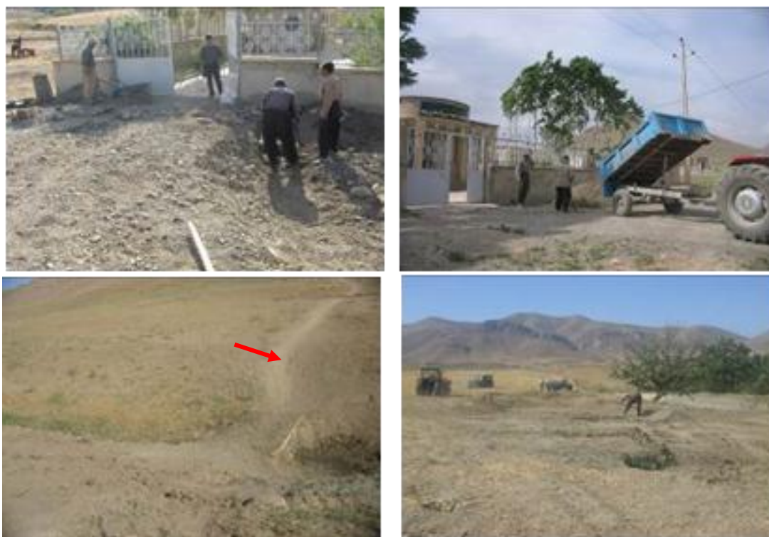
شکل ۵: تصاویری از تسطیح پیرامون ساختمان پایگاه و ایجاد پل جهت تسهیل دسترسی به بالای دژ
