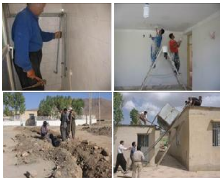
شکل ۳: تصاویری از مراحل مختلف تعمیر و بهینه‌سازی ساختمان اداری و همچنین انتقال مخزن ذخیره آب به همراه لوله‌کشی آب به‌منظور بهبود و ارتقاء زیرساخت‌های ساختمان اداری
