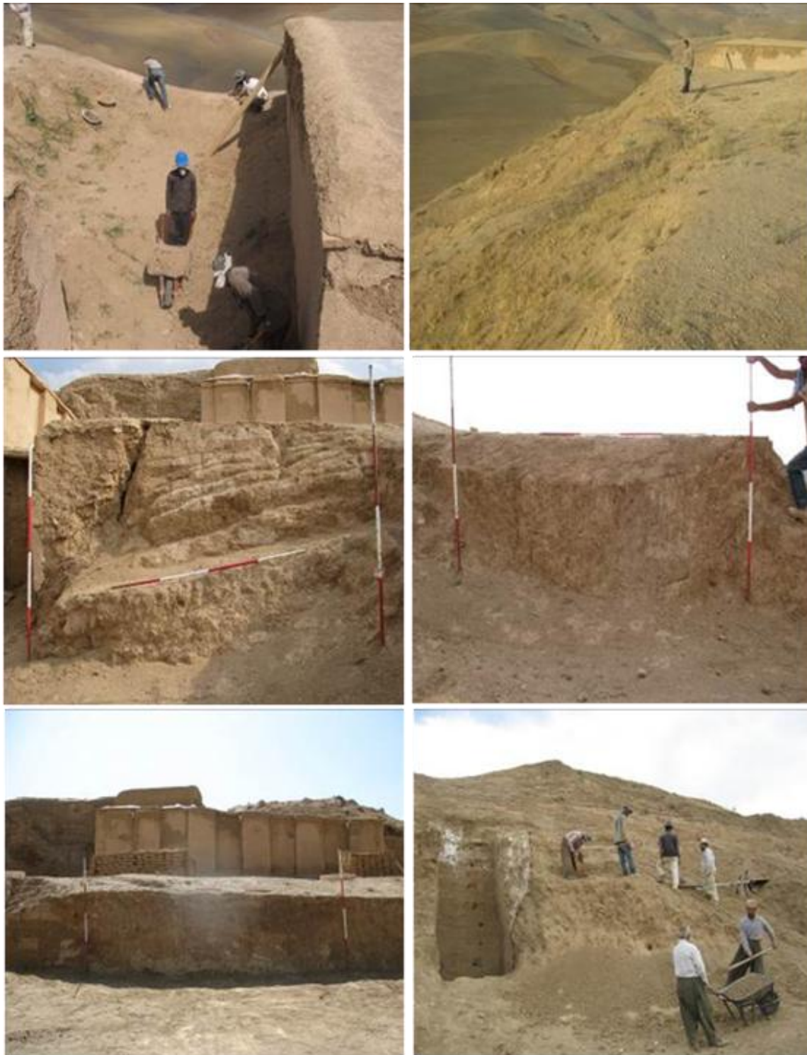
شکل ۷: تصاویری از مراحل خوانا سازی و استحکام بخشی تالار ستون دار که شامل مراحل پیش، حین و پس از انجام کار می‌باشند. این تصاویر نمایانگر فرآیند بهبود و تقویت ساختار تالار ستوندار هستند.
