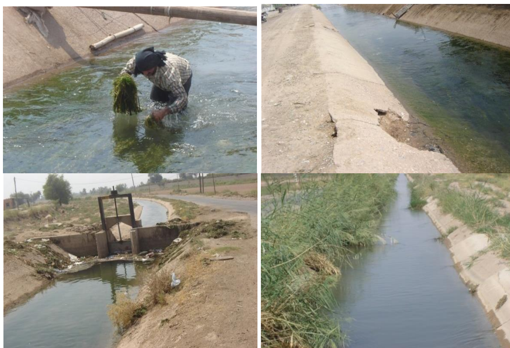
شکل ۴ - تجمع علف های هرز، مشاهده آشغال و جلبک و خزه در کانال فرعی E4
