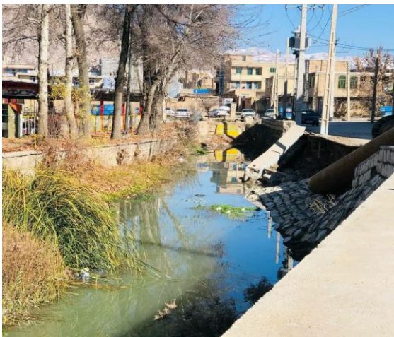
شکل ۱۲: ریزش دیواره‌های اطراف چشمه برم نزدیک به سازه سنگین فلزی مصلای امام خمینی (ره) لردگان
