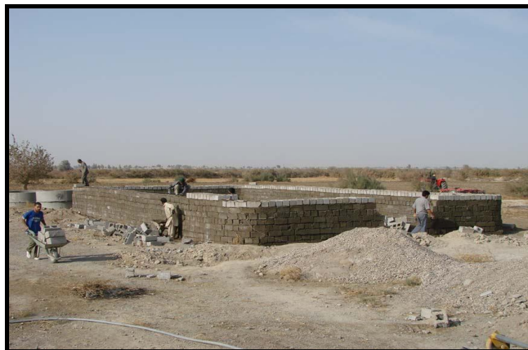
شکل ۲- مراحل طراحی و ساخت استخرهای دو منظوره ذخیره آب کشاورزی در منطقه زابل (نگارنده)
