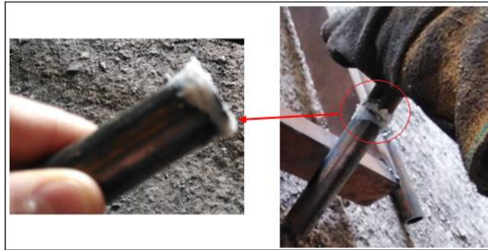
شکل ۳- روش مالیدن نانوفیلر بر سطح اتصال
