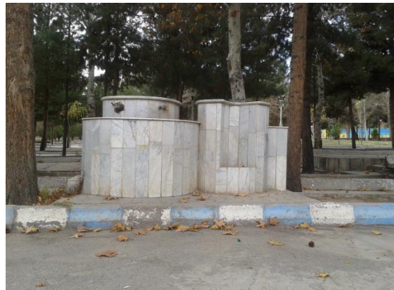
شکل ۱۳- وضعیت آب خوریهای پارک ارم و عدم تناسب آن برای معلولان و افراد ناتوان
