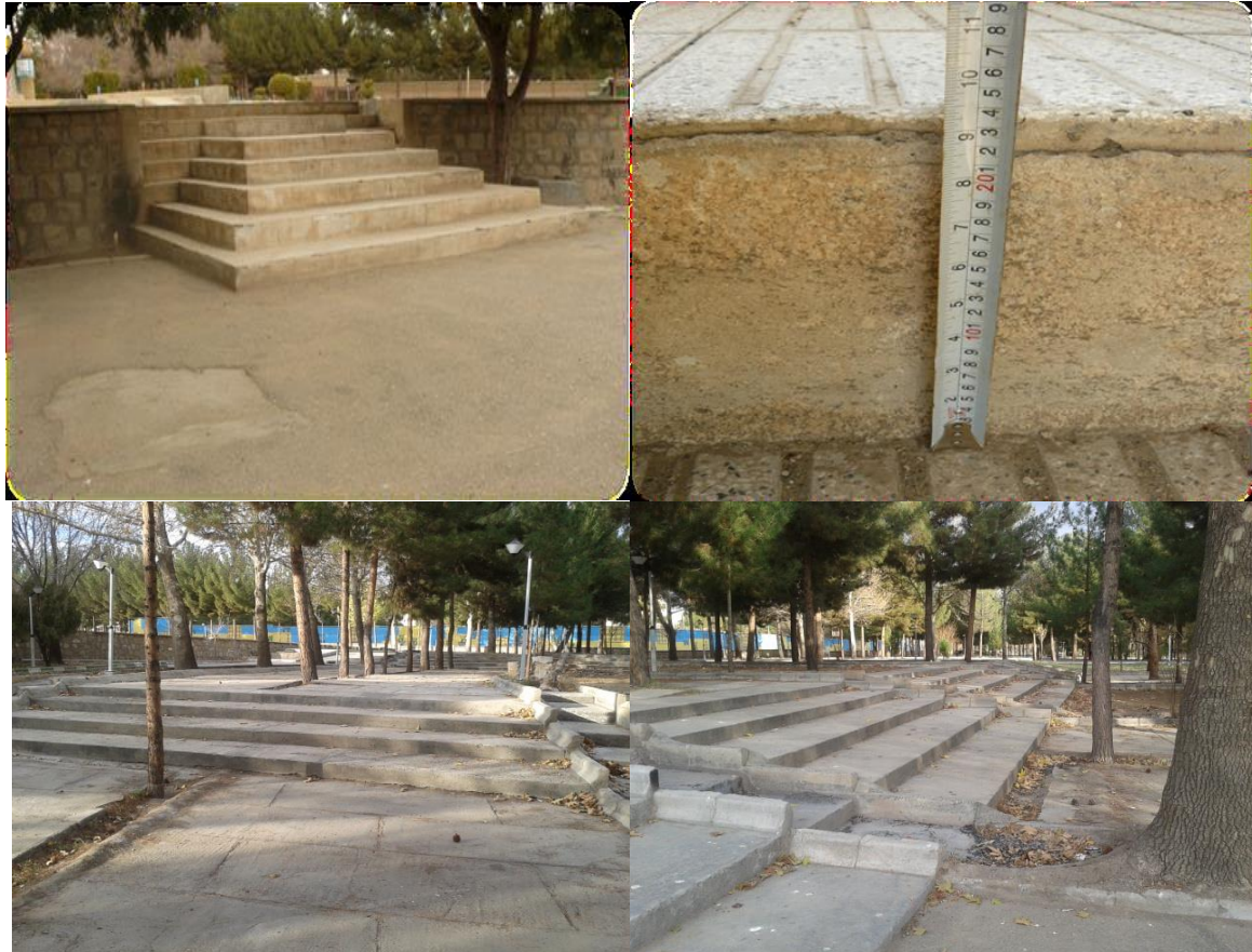
شکل ۱۱- کیفیت نامطلوب پله گذاری ها در پارک ارم به ویژه برای اقشار خاص همانند معلولان و کودکان Figure 11- Unsuitable quality of stairs in Eram Park especially for specific groups such as children and disabled
