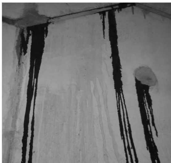
شکل ۵- نشت مواد هیدروکربوری از فاصله بین قطعات پوشش بتنی به داخل تونل
