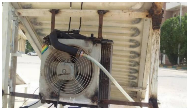
شکل ۶: رادیاتور و نیم‌لوله‌های سیستم خنک‌کننده
