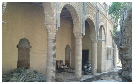
شکل ۶- بهره‌گیری از نیم قوس‌ها در ساختمان راه آهن (منبع: نگارنده، ۱۴۰۱)
