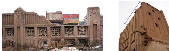
شکل ۱۳- استفاده از آجر به عنوان مصالح اصلی کارخانه بهره‌گیری از تزئینات آجری در جداره‌های کارخانه (منبع: نگارنده، ۱۴۰۱)
