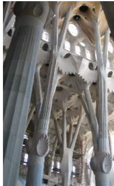
شکل ۵. کلیسای ساگراد فامیلیا اثر آنتونی گائودی ستون ها با الهام از شاخه های درختان (Isaac, 9, 2008)
