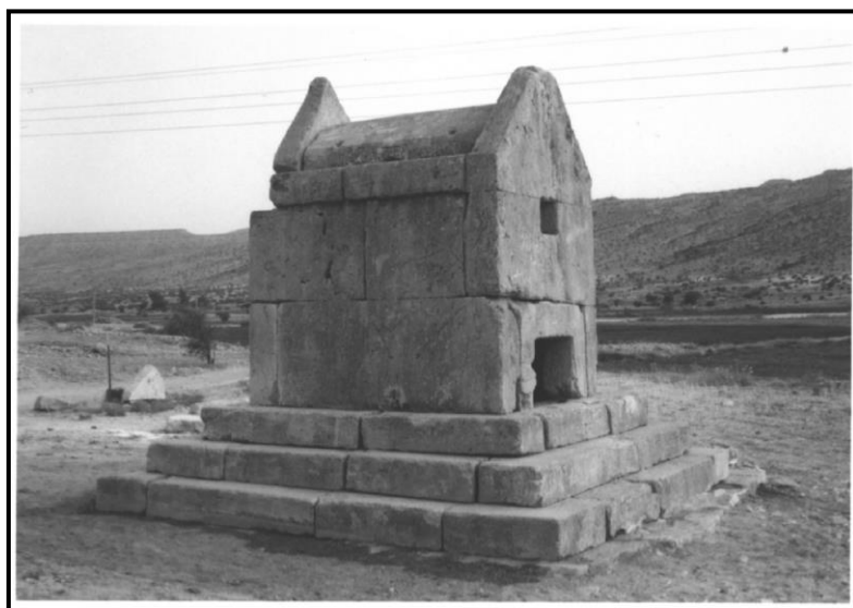
تصویر شماره ۵: نمای کلی از بنای گور دختر بزپر بعد از مرمت دید از شرق. مرمت بنا توسط تیم
