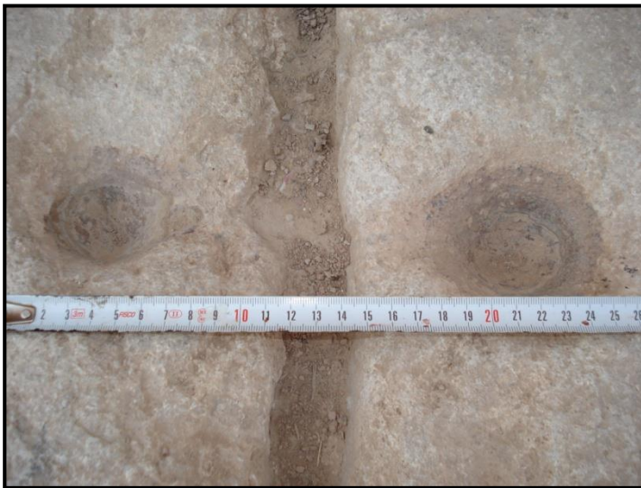
تصویر شماره ۱۳: نمایی دیگر از جای بست های بکار رفته در آرامگاه گوردختر بزپر که دو انتهای آن بصورت مدور می باشد.
