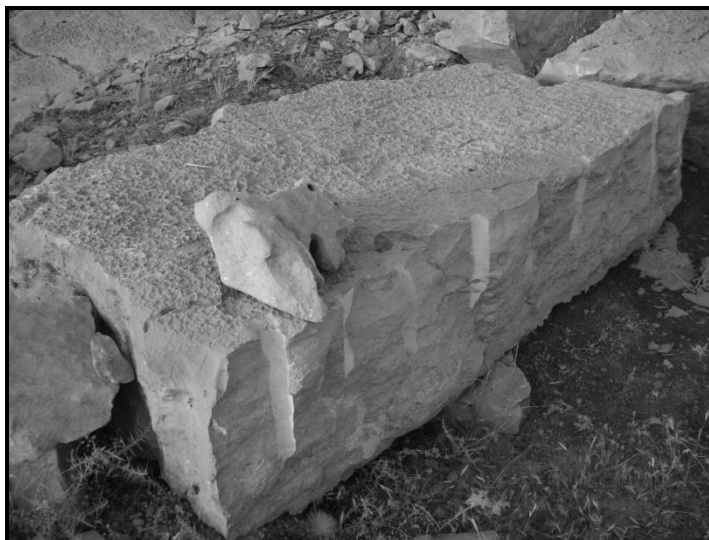
تصویر شماره ۹: نمایی دیگر از سنگهای برش خورده جدید برای مرمت آرامگاه گور
