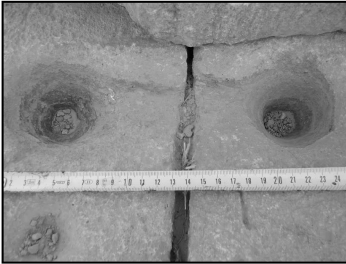
تصویر شماره ۱۲: نمایی از جای بست های فلزی بکار رفته که دو انتهای آن به صورت مدور می باشد ولی اثری از بست ها نمی باشد این نوع بست در کنار درگاه ورودی به کار رفته است.
