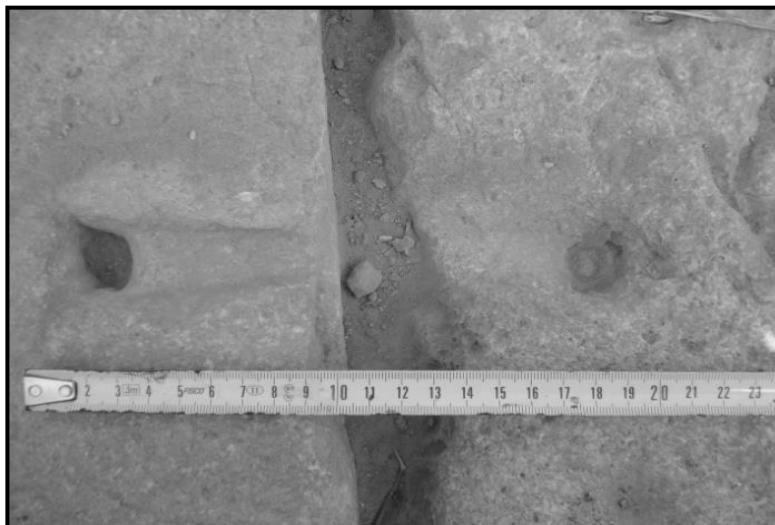
تصویر شماره ۱۶: نمایی دیگر از بست نوع بالا در پلکان آرامگاه گوردختر بزپر
