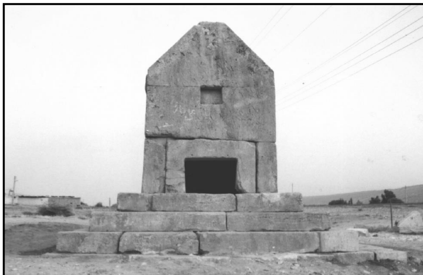
تصویر شماره ۷: نمایی از جبهه شمالی و درگاه ورودی بنای آرامگاه گوردختر بزیر بعد از مرمت، دید از شمال
