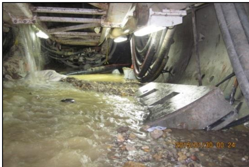
شکل ۶- جریان یافتن مصالح زون گسلی به سمت کاترهد ماشین حفار
