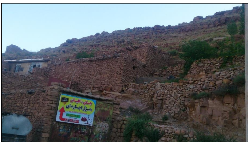
شکل ۷- ساختمان‌های ورودی روستای اسفیدان در خطر سنگ افتان ۴۰ UTM 4131438 S 550933
