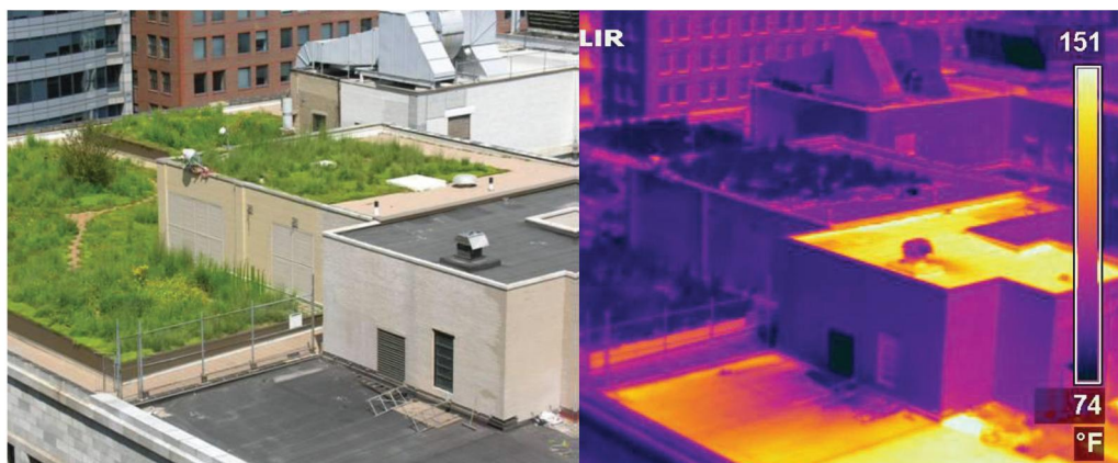
شکل ۳- در یک روز عادی، بام سبز شهرداری شیکاگو حدود 40^{\circ}\text{C} خنک‌تر از بام متداول ساختمان مجاور است (اسپینگر، ۲۰۱۲).
