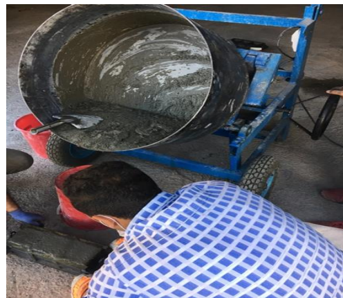
شکل ۷- قرارگیری بتن درون قالبهای استاندارد [۱۲].
