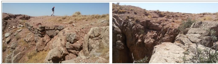
شکل ۳- قسمتی از دیواره‌های خشکه‌چین بخشی از حصار قلعه (نگارندگان، ۱۳۹۹)
