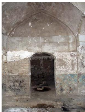
تصویر ۱۹: درب ورودی خزینه آب گرم از طریق گرمخانه (همان)
