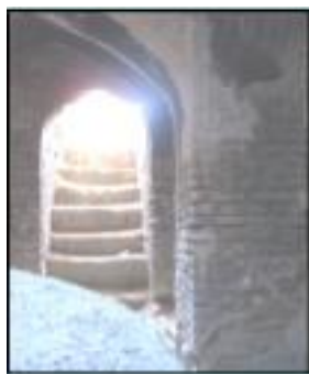
تصویر ۲۱: فضاهای جانبی آب انبار (همان)
