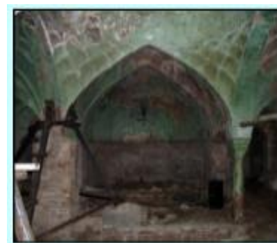
تصویر ۱۰: نمای ستونهای جنوب شرقی و شمال شرقی و قوس جناغی روی آنها (عکس از نگارنده)
