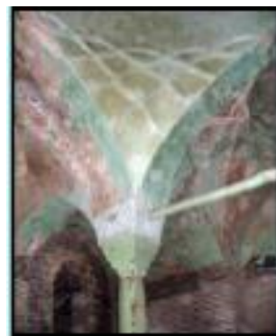
تصویر ۸: نمای ستون جنوب شرقی سرپینه با تزیینات آهکبری (عکس از نگارنده)
