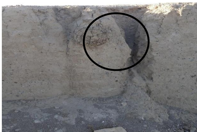
تصویر ۱۲. بقایای اتصالات چوبی در دیواره شمالغربی (نگارنده)
