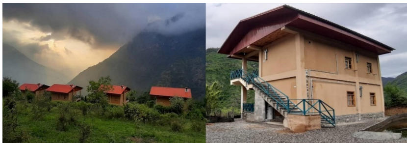
تصویر ۲. ساختمان اقامتگاه بومگردی واقع در ریگ چشمه (نگارندگان)
