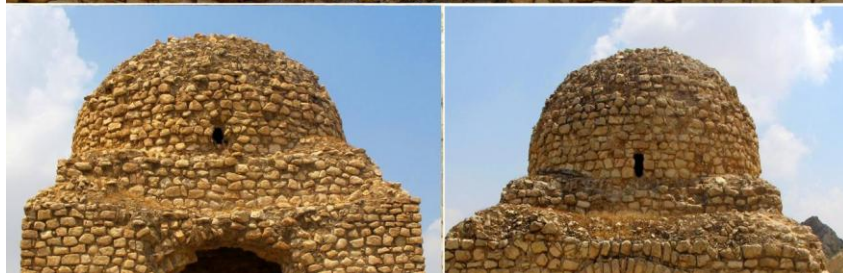
تصویر ۱۵: گنبد چهارطاقی متشکل از سه طبقه (عکس از نگارندگان).
