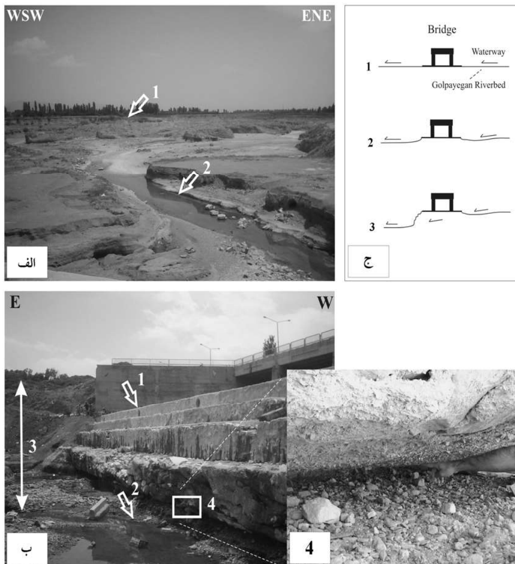
شکل ۷- الف) پادگانه های آبرفتی و فرسایش قائم دشت گلپایگان. شماره ۱ قدیمی ترین و شماره ۲ و جدیدترین سطح فرسایش دشت گلپایگان می باشد. ب) فرسایش قائم در دشت گلپایگان در حاشیه یکی از پل های ارتباطی شهر. شماره ۱ نشان دهنده سطح قاعده بتونی پل در هنگام ساخت پل می باشد و شماره ۲ سطح فعلی رودخانه را نشان می دهد. میزان فرسایش قائم کلی رودخانه گلپایگان در طی زمان های گذشته با شماره ۳ مشخص شده است. شماره ۴ محل عبور آب را از زیر قاعده پل نشان می دهد. ج) شکل نمایشی از وضعیت پل رودخانه گلپایگان و بستر آن. در این شکل، شماره ۱ وضعیت پل و بستر رودخانه را در هنگام احداث پل نشان می دهد. در شماره ۳ با افزایش فرسایش قائم، رودخانه بستر خود را حفر نموده و آب از زیر قاعده بتونی پل راهی برای عبور باز نموده است. شماره ۳ را با شکل ۷-ب مقایسه کنید.
