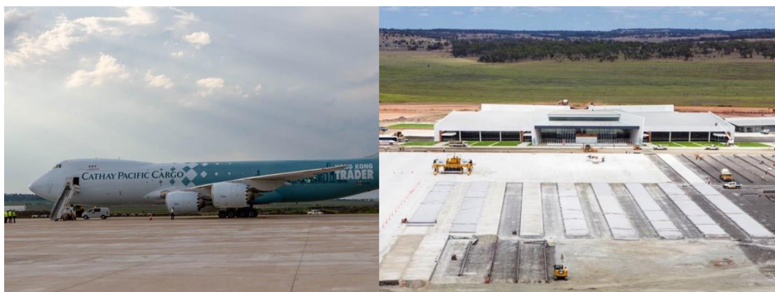
شکل ۱. فرودگاه BWWA کوئینزلند استرالیا (بزرگترین پروژه بتن ژئوپلیمری مدرن که مطلقاً فاقد سیمان پرتلند است)
