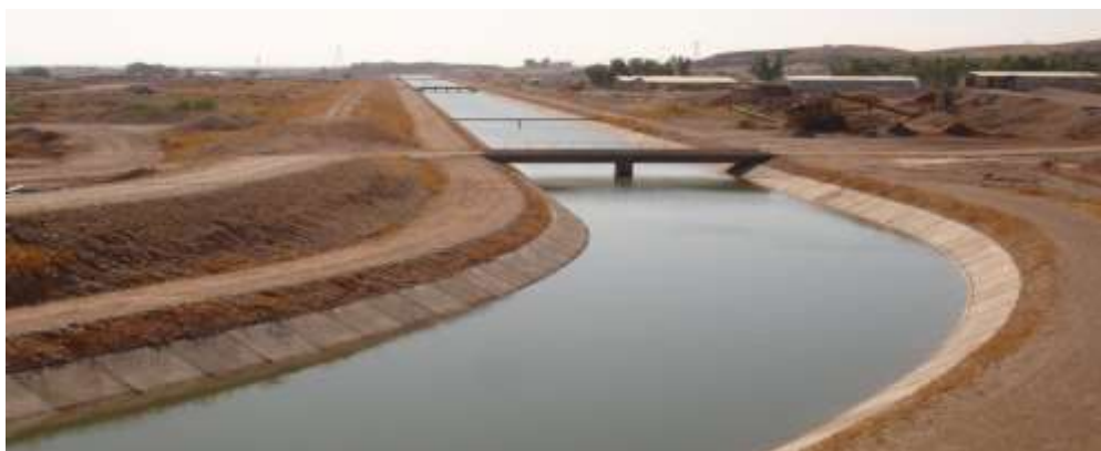
شکل ۲: کانال اصلی پای پل
