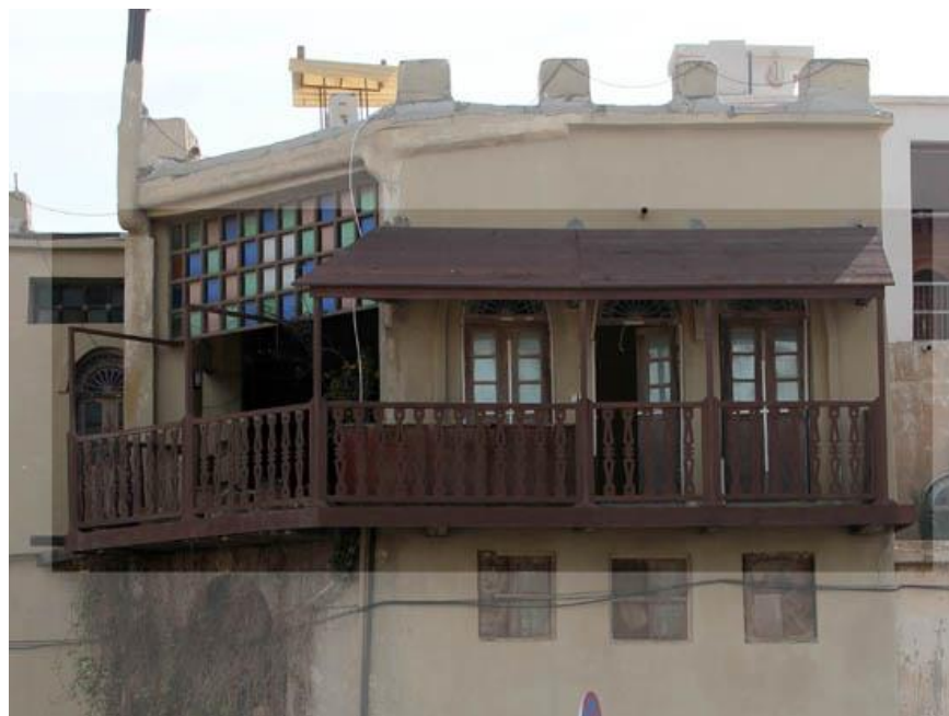
شکل ۵: طارمه و شناسیل خانه مسکونی در نواحی ساحلی مناطق گرم و مرطوب، بوشهر
