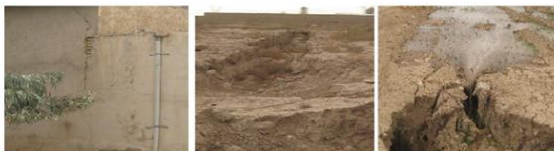
شکل ۹- آثار فرونشست زمین در منطقه معین‌آباد پیشوا
