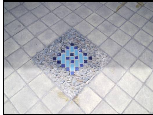
تصویر ۱۱- دو نما از پوشش کف محوطه هتل باغ مشیرالممالک بعد از بازسازی [ منبع: حسین امجد ]
