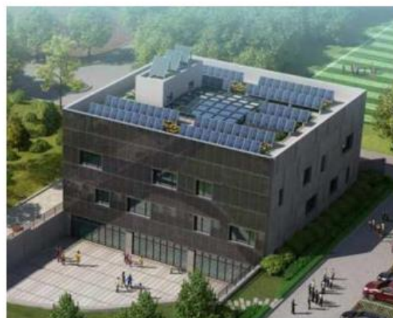
شکل ۵- (الف) نتیجه شبیه سازی طرح سیستم فتوولتائیک پشت بام، و (ب) نمای هوایی در سازمان پسماند شهری تبریز Fig 5- (a) The result of the simulation of the rooftop photovoltaic system design, and (b) the aerial view in the urban waste organization of Tabriz
