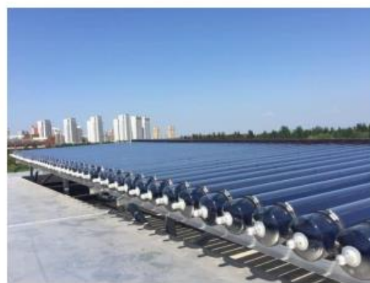
شکل ۶- (الف) نمونه سیستم پیشنهادی سیستم فتوولتائیک در پشت بام، و (ب) نمونه پیشنهادی کلکتورهای گرمایی خورشیدی برای آب گرم Fig 6- (a) The proposed system example of photovoltaic system on the roof, and (b) the proposed example of solar thermal collectors for hot water
