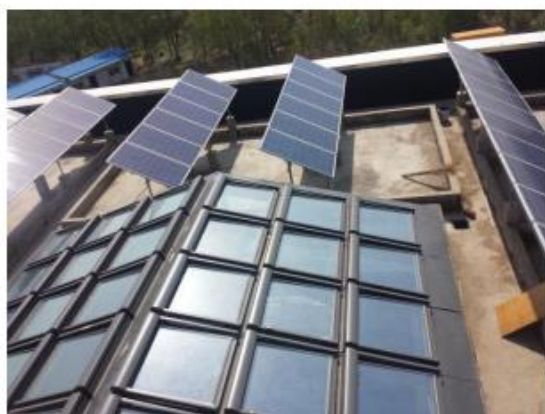
شکل ۶- (الف) نمونه سیستم پیشنهادی سیستم فتوولتائیک در پشت بام، و (ب) نمونه پیشنهادی کلکتورهای گرمایی خورشیدی برای آب گرم Fig 6- (a) The proposed system example of photovoltaic system on the roof, and (b) the proposed example of solar thermal collectors for hot water
