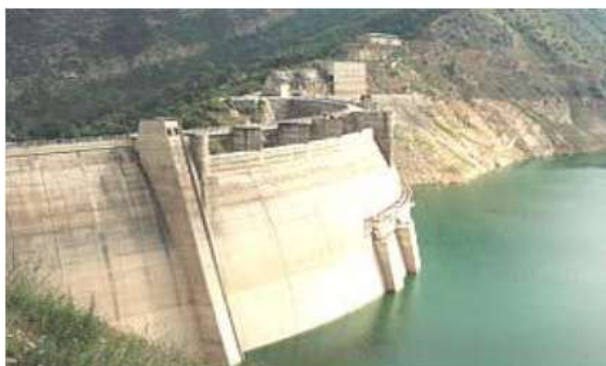
شکل ۱. سد شهید رجایی در جنوب‌غربی شهر ساری
