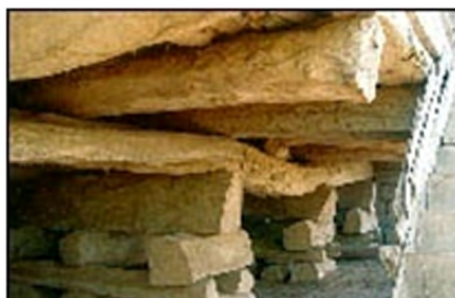
شکل ۵. راست: نما و برش از یک ساختمان مسکونی متداول در ناحیه شرقی جلگه سفیدرود (بیه پیش)، (ماخذ: حائری مازندرانی، ۱۳۸۸، ۷۸). چپ: احداث پاچه برای ساخت بی، (ماخذ: طالقانی و همکاران، ۱۳۸۶، ۶۴).
