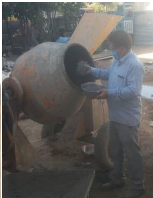
شکل ۲- اضافه کردن الیاف فولادی به بتن در حین اختلاط بتن در دستگاه بتو نیر
