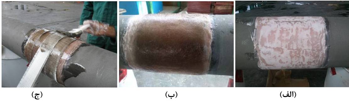
شکل ۲- مراحل گوناگون لایه‌زنی روی لوله، الف) چسب اپوکسی اعمال شده روی لوله پس از پخت و آماده‌سازی سطح، ب) الیاف سوزنی اعمال شده روی لوله، ج) اعمال پارچه سوزنی ۲ بعدی
