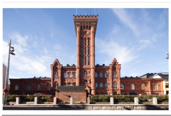
شکل ۶. ایستگاه آتش‌نشانی هلسینکی (Archinfo Finland, 2020)
