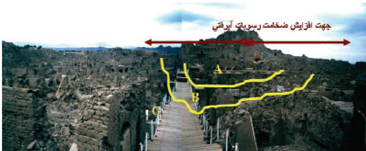
تصویر ۴- تقسیم بندی میزان خسارات وارده به ارگ قدیم بم. A: پی سنگی با میزان خسارت کم، B: پی بر روی آبرفت با ضخامت کم با میزان خسارت زیاد، C: پی بر روی آبرفت با ضخامت خیلی زیاد با میزان خسارت بسیار زیاد
