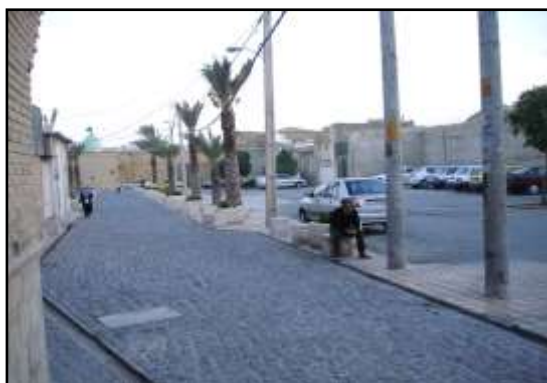
شکل ۹. ایجاد پارکینگ، کف‌سازی، مبلمان و فضای سبز، گذر سنگ سیاه در مجاورت بازارچه‌ی آرامنه
