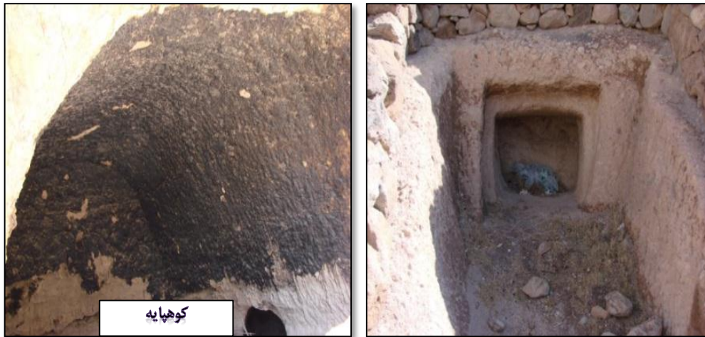
شکل ۸. استفاده از حفاری قوسی شکل تاق بیز در کوهپایه کرمان
