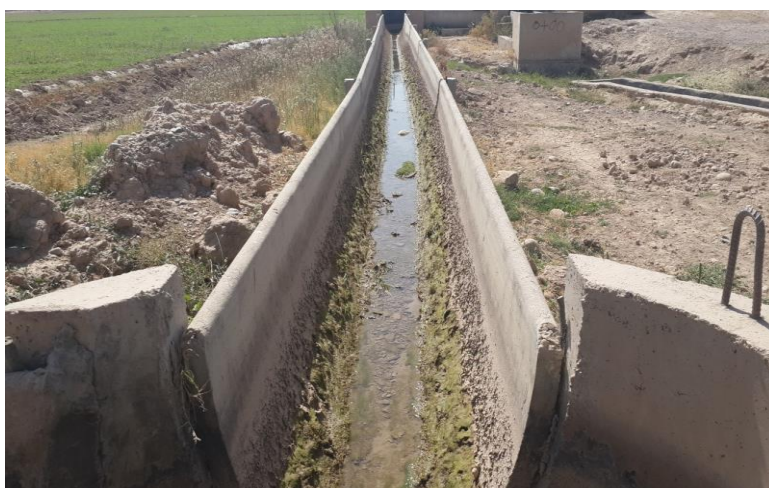
شکل ۲- رسوب گرفتن داخل کانالت و سازه مقسم
