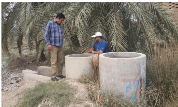
شکل ۱۳- سازه آبگیر دوقلو و حوضچه ابتدای نهر درجه ۴
