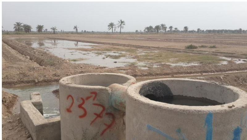
شکل ۱۶- آبخویی قطعه زراعی و زهکش روباز جهت جمع آوری آب و هدایت آن به زهکش درجه ۲
