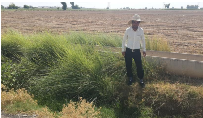
شکل ۳- نشت آب از کانالت و رویش علف های هرز
