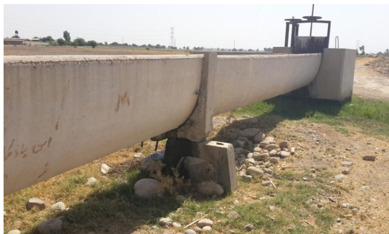
شکل ۶- بر خورد ماشین آلات با کانالت که باعث خارج شدن آن از محور و ریزش آب و عدم باز سازی آن
