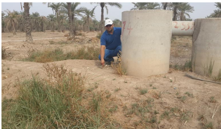
شکل ۱۲- نشان دادن شافت باز و بستن شیر ورودی به سازه ابتدای نهر درجه ۴
