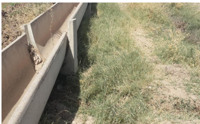
شکل ۷- شکستن زین و آفتادن کانالت از روی آن در اثر برخورد ماشین آلات و عدم تعمیر اصولی آن
