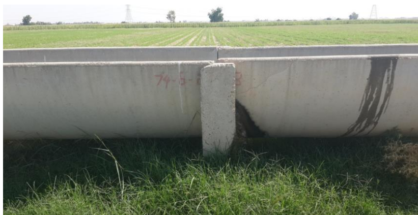
شکل ۵- ریزش آب از کانالت و رشد علف های هرز
