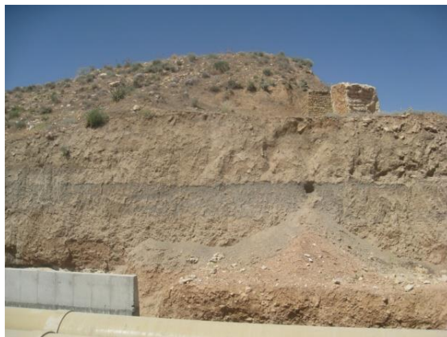
تصویر ۸: لایه سیاه‌رنگ (لجن) که پایه سد روی آن قرار گرفته
