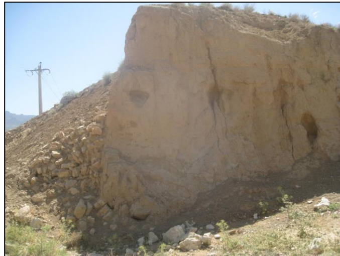
تصویر ۶: جزئیات دیواره سد با هسته خاکی و بدنه لاشه سنگی
