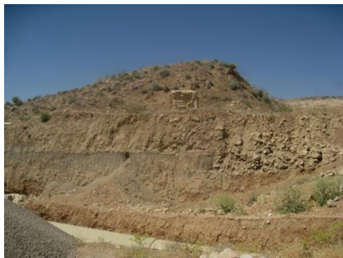
تصویر ۱۰: هسته خاکی و پوشش لاشه‌سنگی دو سمت آن در برش دیواره غربی
