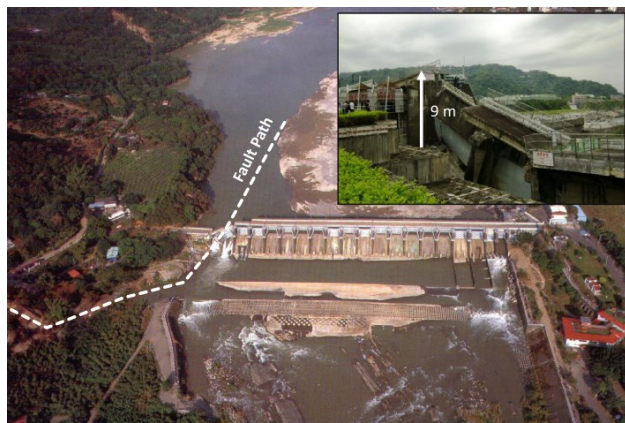
شکل ۱- آسیب به سد Shih Kang ، به دلیل جابجایی ۹،۱ متری گسل Chelungpu زلزله Chichi-taiwan در سال ۱۹۹۹ [۵].
