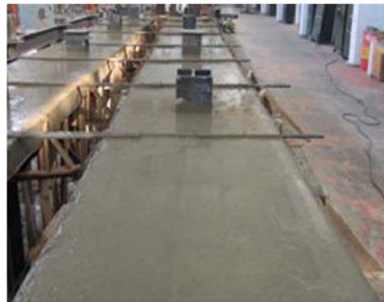
شکل ۴- تصویر تیر پس از بتن ریزی
