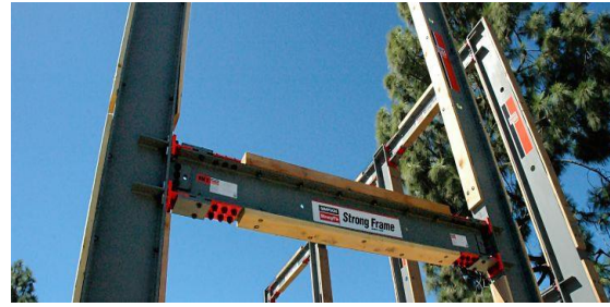
شکل ۲- نمونه‌ی اجرایی اتصال درختی سپری سیمپسون
