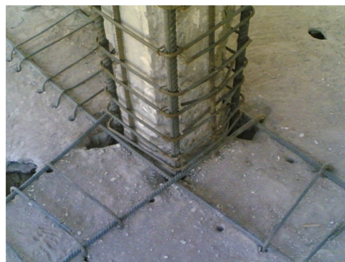
شکل ۶- نمای بالا از محل اتصال تیر به ستون، تقویت‌شده به روش غلاف‌بندی بتن مسلح
