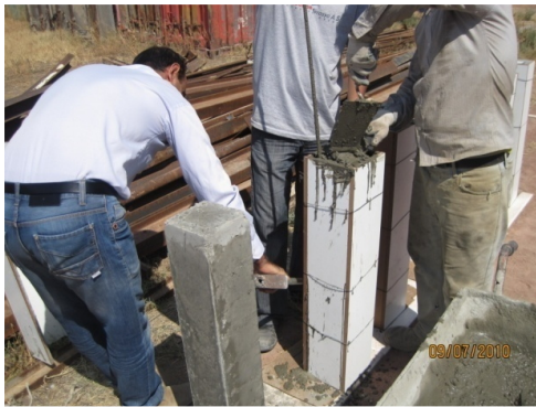
شکل ۱۵- تصویر مربوط به بتن‌ریزی مقاوم‌سازی
