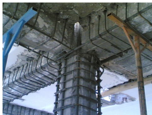
شکل ۵- نمای پایین از محل اتصال تیر به ستون، تقویت‌شده به روش غلاف‌بندی بتن مسلح
