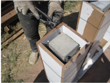
شکل ۱۴- تصویر مربوط به نگهداری بتن در محل دقیق خود
