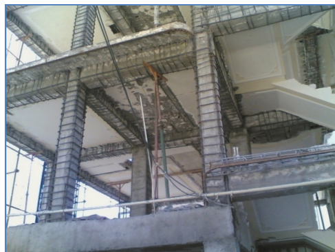
شکل ۴- تیرها و ستون‌های تقویت‌شده در یک ساختمان به روش غلاف‌بندی بتن مسلح
