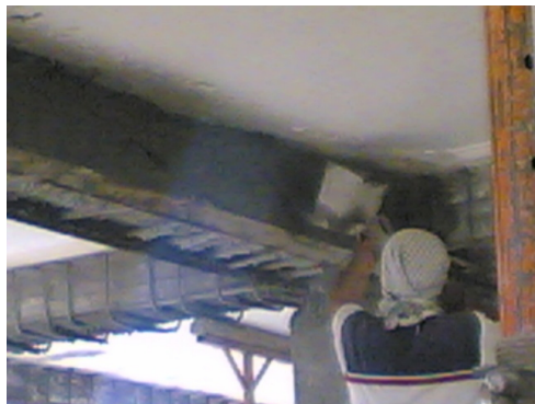
شکل ۷- عمل شاتکریت بر روی غلاف بندی فولادی انجام شده
