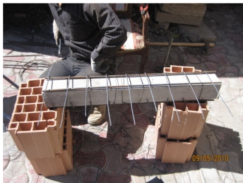
شکل ۱۱- تصویر مربوط به مراحل غلاف‌بندی
