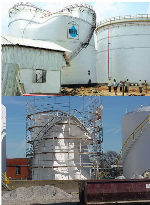
شکل ۱- تصویر دو نمونه از فرورویختگی‌های مخازن جدار نازک است.
