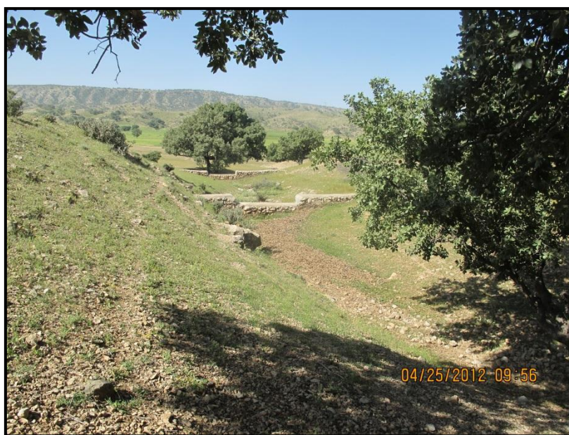
شکل ۱۲- مهار فرسایش و رسوب به وسیله‌ی سدی اصلاحی در حوضه‌ی جونگان ممسنی.
