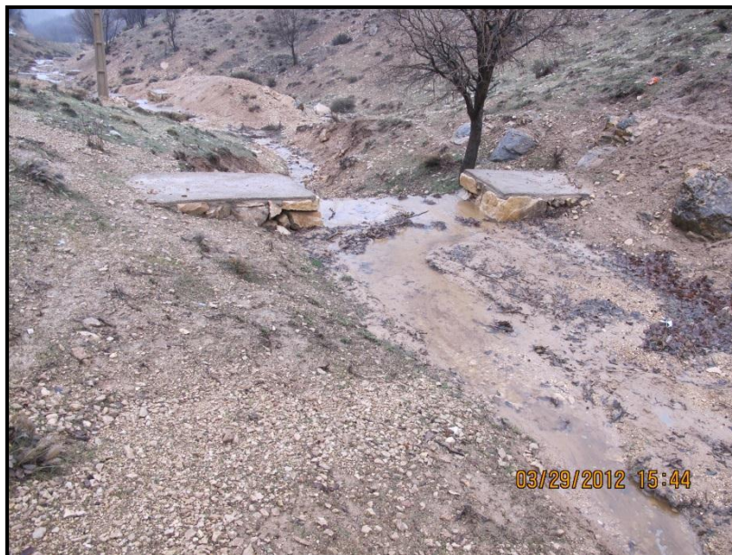
شکل ۱۱- مهار کردن فرسایش و رسوب به وسیله‌ی سدی اصلاحی در حوضه‌ی تنگشول مرودشت.
