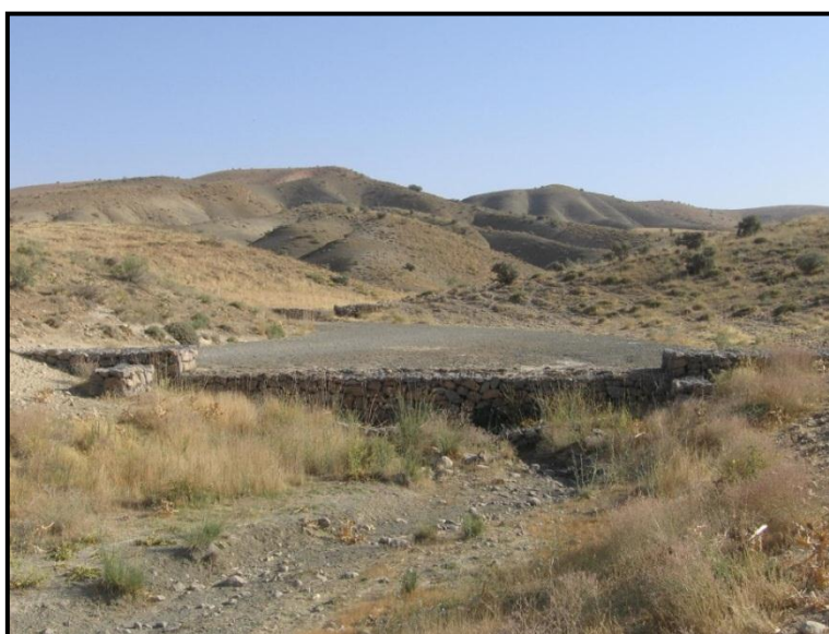
شکل ۱۰- مهار کردن فرسایش و رسوب به وسیله‌ی سدی اصلاحی در حوضه‌ی طویله‌بند اقلید.
