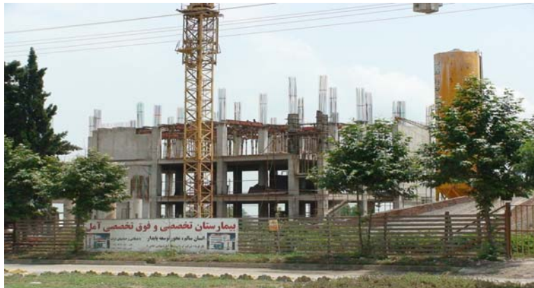
شکل شماره ۳: تصویر ساخت بیمارستان فوق تخصصی آمل - تیرماه ۱۳۸۷
