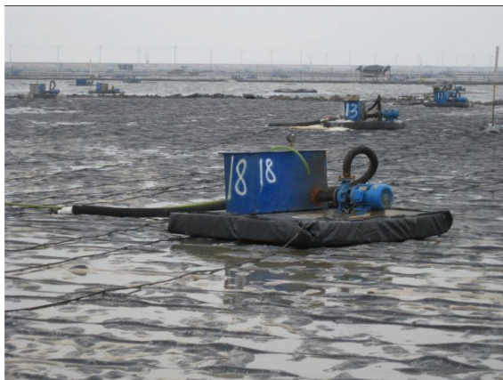
شکل 4: نمایی از پمپ یک پروژه تحکیم با خلاء
