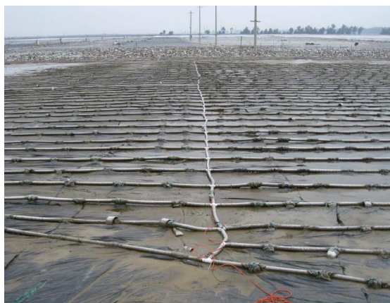
شکل 5: نمایی از سیستم جمع آوری آب های سطحی از PVD های نصب شده در زمین
